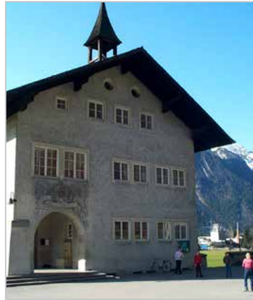
Die Volksschule Bings wird im kommenden Jahr umfangreich saniert.
