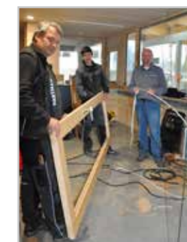
Auch das „ASZ-Büro“ ist schon fast fertig
