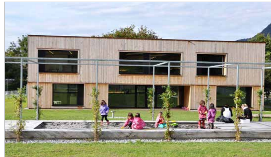
Der Stadt war bei diesem Bauprojekt die Nutzung der heimischen Hölzer wichtig.
